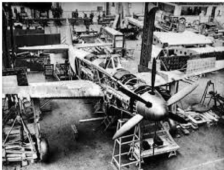
VB 10 en cours de construction à l'Arsenal de l'Aéronautique
